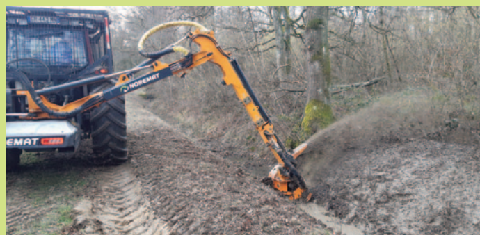
Test de l'entretien des fossés à l'aide d'une tête rotative montée sur un bras d'épareuse
