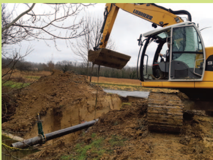
Travaux de réparation du trou de l'étang Page
