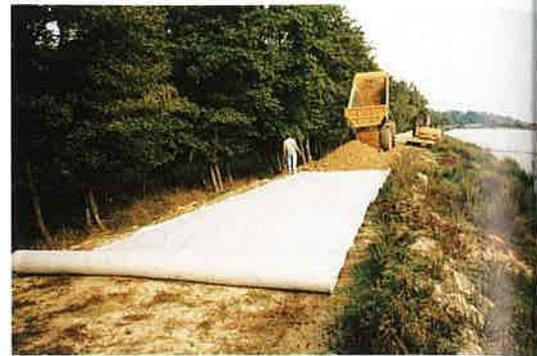
Le géotextile a été déroulé sur le terrain nivelé, avant l'empierrement
