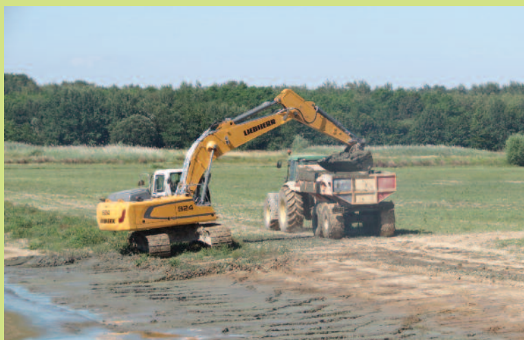
Curage de la pêcherie et du bief principal de l'étang Praillebard (Photo : T. BEROUD /FPV)
