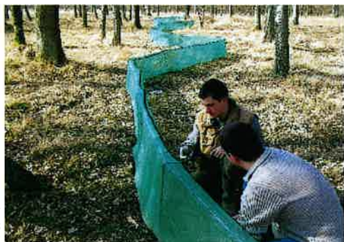
Une barrière de grillage en cours d'installation en vue de détourner les animaux vers un point de passage où un dispositif permet de les dénombrer.
