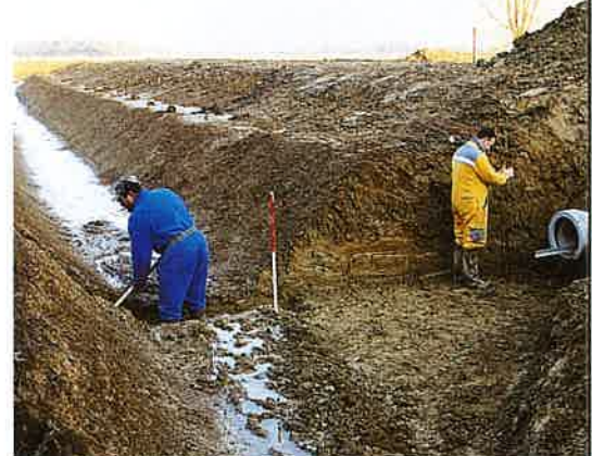
A voir l'étang achevé et ses eaux "calmes et lisses", imagine-t-d'infrastructure que sa réalisation a nécessités ? On voit ici l'aménagement d'un embie - petit affluent par lequel versant s'écoulent vers l'étang. Il y a quatre autres entrées d'e
