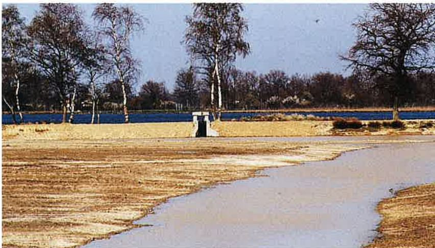
Voici le thou remis à neuf. Le bief central et la pêcherie sont en cours de remplissage. A l'arrière plan, l'étang Boufflers avec ses eaux aux couleurs d'un bleu roi.
