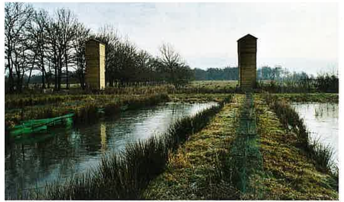
Vue sur l'ensemble des installations dévolues aux tortues
